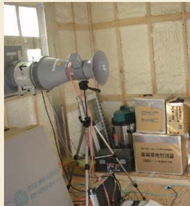
▲タツミホームで建てられた住まいは、すべて完成後に気密測定を行っています。
