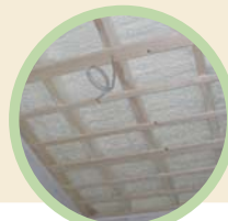
▲断熱検査天井
