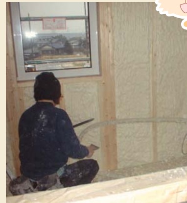
▲細部までムラなく発泡ウレタンを吹き付け、安定した断熱・気密性を実現。
