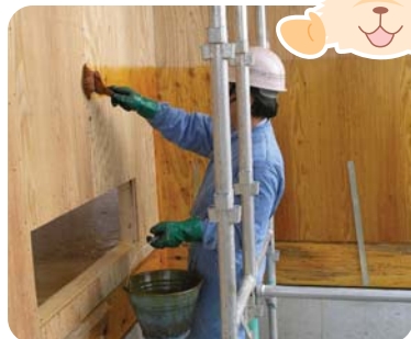
▲白蟻防蟻防蟻工事の様子
